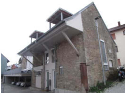
Sanierung ortsbildprägender Stein- gebäude und Schaffung Quartiers- garage, Reichenberg
