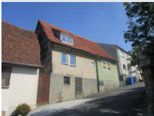
Sanierungsbedarf am Geisberg, Reichenberg
