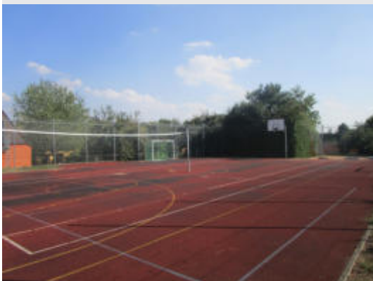
Hartplatz an der Schule/Kita, Reichenberg
